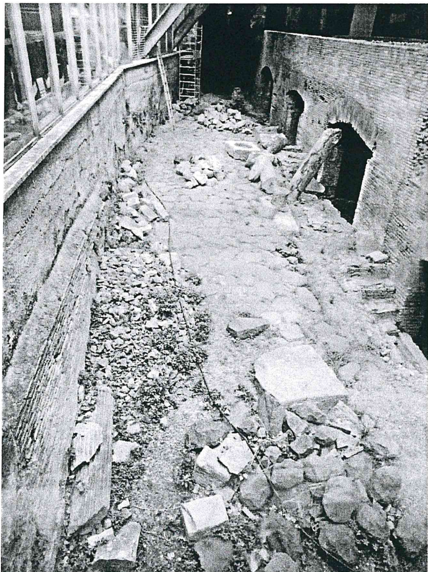
Vista del basolato stradale dopo l'intervento di pulizia.
